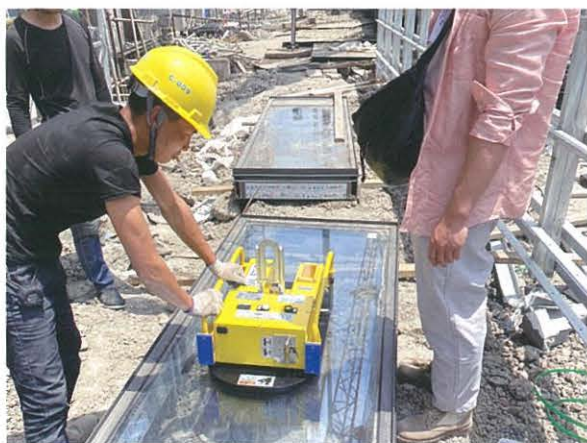
室外单元板块幕墙安装 直流单爪吸吊设备 HP-GI500-1S (500KG)
